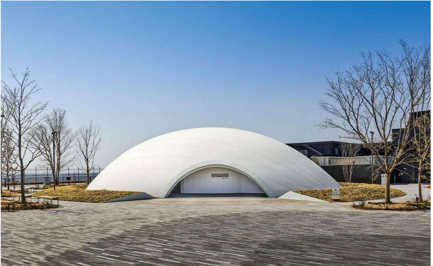
このドームは、材料起源のCO<sub>2</sub>排出を抑える「ECMコンクリート®」と、製造時にCO<sub>2</sub>を吸収・固定する「CO<sub>2</sub>-SUICOM®」という、同社が中心となって開発した複数の特許技術を組み合わせて実現された[ [151](#)][[212](#)][[220](#)]。これは、NEDOのグリーンイノベーション基金事業として設立されたコンソーシアム「CUCO®」の成果であり、オープンイノベーションによる脱炭素技術開発の成功事例となっている[ [151](#)]。
